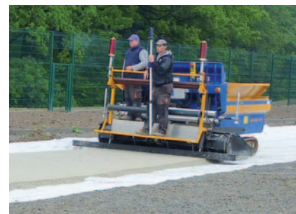
Praca przy budowie boiska
